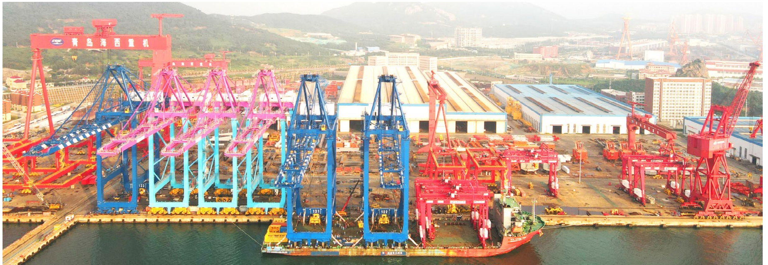
▲ 一批岸桥、自动化轨道吊运至韩国釜山新港
